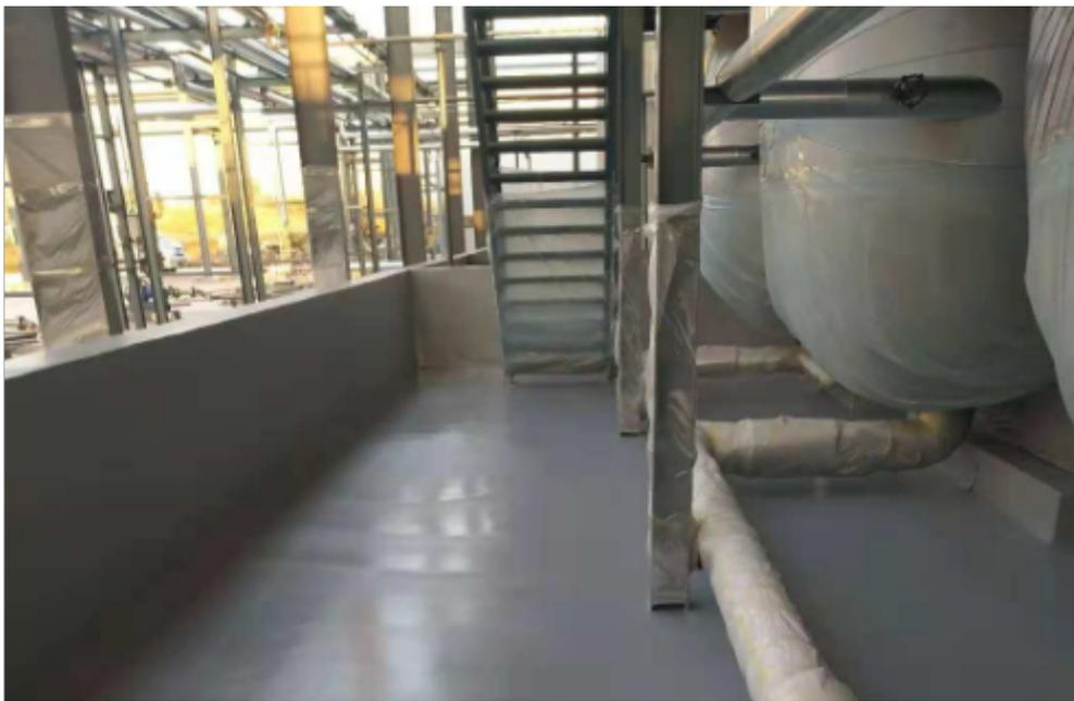
聚脲地坪产品在包装物中为浓稠液体状。一旦遇到空气则发生化学交联而固化。固化后形成一种聚脲弹性橡胶膜。该材料对混凝土砂浆、大理石、陶瓷、铝合金、聚氨酯发泡剂PVC等有较好的粘附力。一般情况下,建议使用合适的底涂剂,以使其对基材有更好的粘结性能。在PU保温层平整面上和XPS板上可不用底涂剂。材料固化后,其可直接暴露于室外空气中使用,颜色不发生改变,无须保护层。其具有优异的防水性能和耐磨性能。其可承受车辆的磨压,可供行人,车辆通行。适用范围:1、上人、上车的暴露屋面或桥面、平台、站台、停车库的防水耐磨工程2、其它需调色的暴露防水工程3、上人、上车的室内外地坪工程4、体育场看台表面防水耐磨工程5、阳台表面的防水耐磨工程6、游泳池防水7、水利大坝、水电站防水8、桥梁、隧道防水工程9、其他暴露防水和保护工程。青海手工聚脲防腐施工山东德士力新材料科技有限公司将产品打造成家喻户晓的质量品牌。
